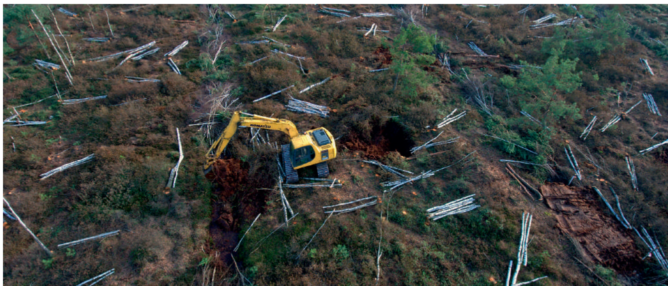
Durpės užtūrai kasamos vietoje, keletą metrų aukščiau statomos užtūros Peat for dam construction is taken few meters upstream
