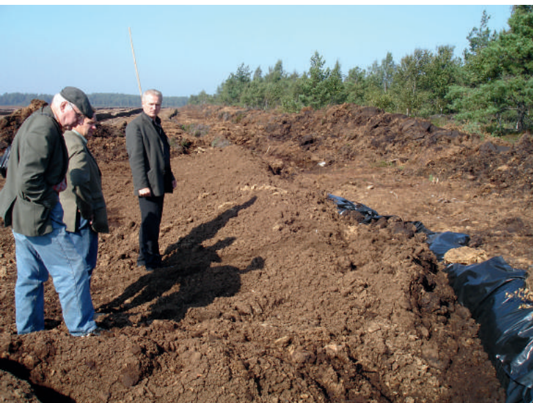
Durpyno ir išlikusias aukštapelkės sąlyčio zonoje įrengta 1 km ilgio tiesioginį vandens nutekėjimą iš aukštapelkės į durpyną stabdanti eksperimentinė priemonė su polietilenu membrana, Aukštumalos telmologinis draustinis, Šilutės r., 2006 ir 2007 m. 1 km long experimental polyethylene membrane was installed to stop the direct water outflow from the bog to the mining peatland in the Aukštumala Telmological Reserve, Šilutė district, in 2006–2007.
