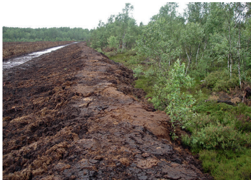
Durpyno ir išlikusias aukštapelkės sąlyčio zonoje įrengta 1 km ilgio tiesioginį vandens nutekėjimą iš aukštapelkės į durpyną stabdanti eksperimentinė priemonė su polietilenu membrana, Aukštumalos telmologinis draustinis, Šilutės r., 2006 ir 2007 m. 1 km long experimental polyethylene membrane was installed to stop the direct water outflow from the bog to the mining peatland in the Aukštumala Telmological Reserve, Šilutė district, in 2006–2007.
